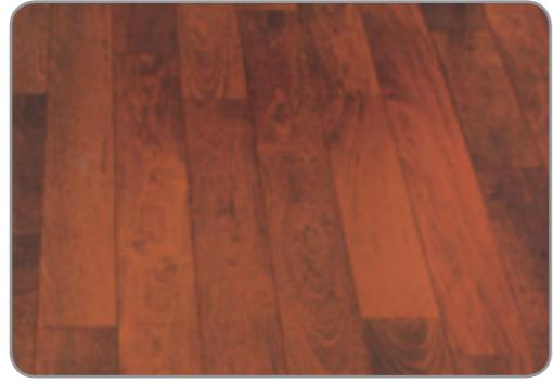
Hierbij worden lange en korte latten met elkaar gecombineerd. Het is dus een afwisselende legmethode waarbij de voegen niet met elkaar zijn verbonden. Deze methode is snel en zeer zuinig, aangezien er niets van het product verloren gaat.
