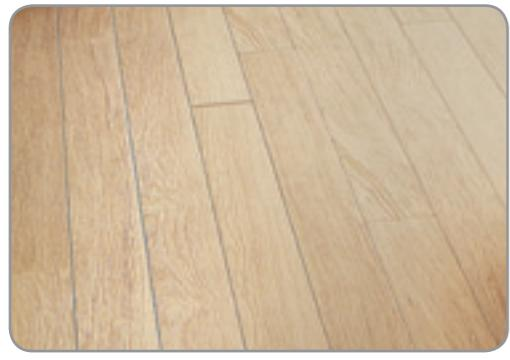
Met deze legmethode wordt de volledige lengte van de lat gebruikt die minstens 50 cm moet zijn. Indien u de lange latten in de lengte van de kamer legt, lijkt deze bovendien groter.
